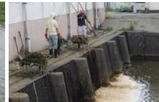
スクリーンの除塵作業
