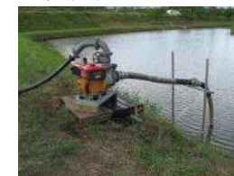
応急ポンプの設置・運転
