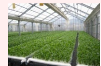
農業生産施設(水耕栽培ハウス)
