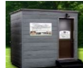
トイレ(固定式)
