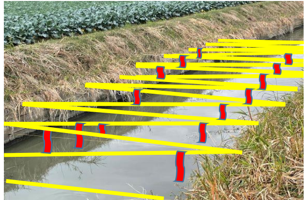
水路テグス設置
