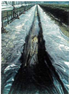
【ハウス周辺の排水溝】 （マルチ展張で崩れ・雑草・浸水防止）
