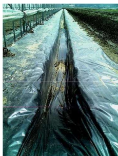
【ハウスの周辺の排水路】 （マルチ展張で崩れ・雑草・浸水防止）
