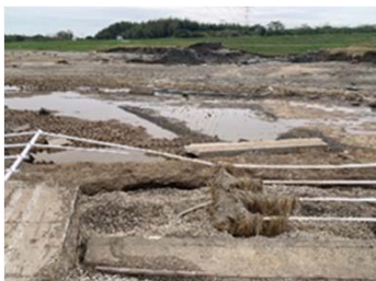
大規模な浸水被害を受けたほ場
